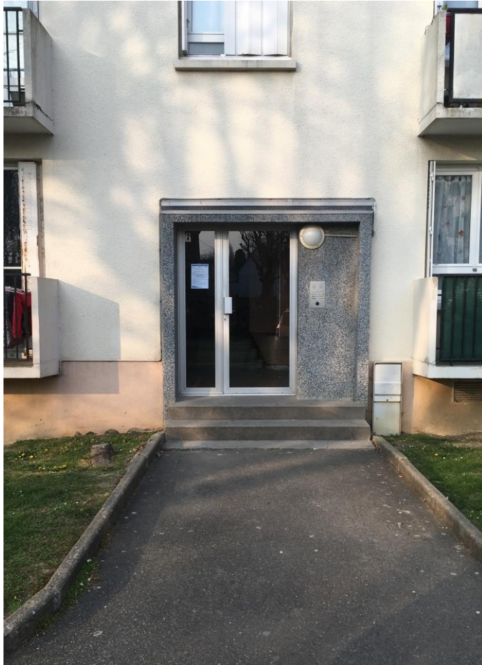
Entrée de l'immeuble. Etat 2019. Photo Eric Lesné.
