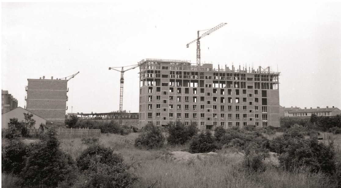
Photo de chantier. Fonds Lesné-Bernadac.
