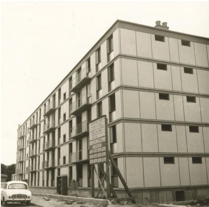
Photo de chantier. Fonds Lesné-Bernadac.
