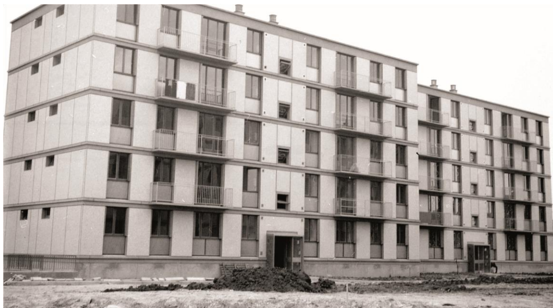
Photo de chantier. Fonds Lesné-Bernadac.
