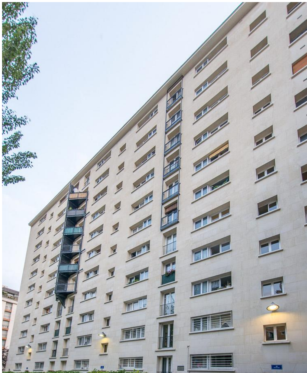
Etat 2017. Façade réhabilitée récemment. Photo Arnaud Lesné.
