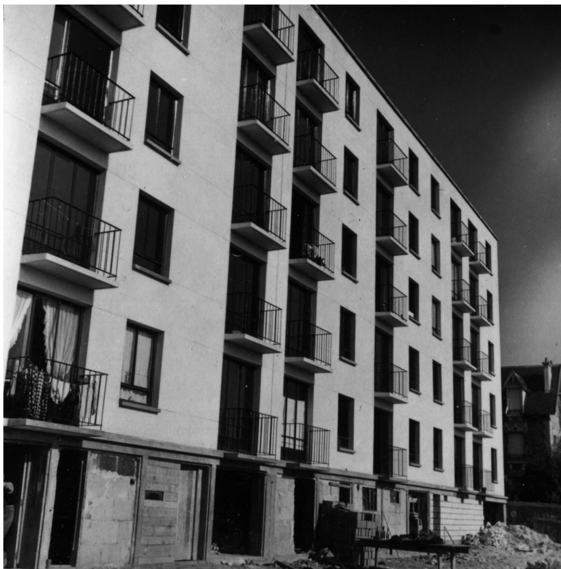
Photo de chantier. Fonds Lesné-Bernadac.
