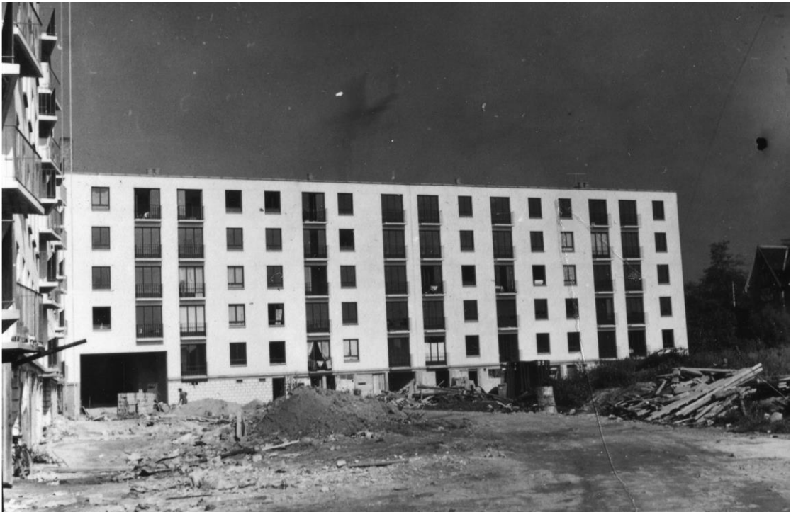
Photos de chantier. Fonds Lesné-Bernadac.
