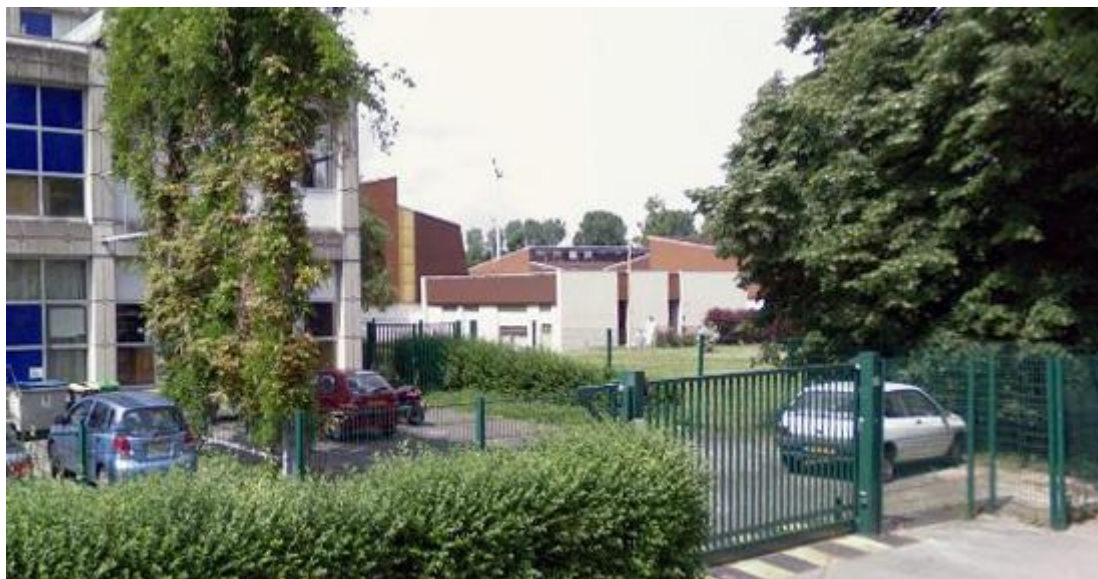
État 2016. Vue du gymnase (détruit) au deuxième plan.
