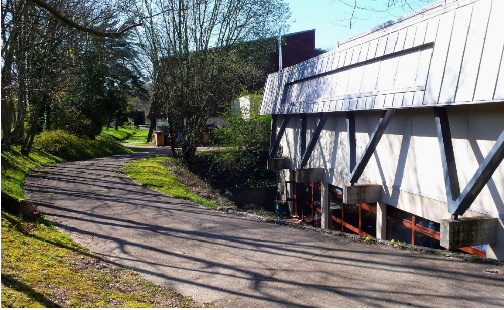
État 2019. Façade extérieure. Photo Eric Lesné.
