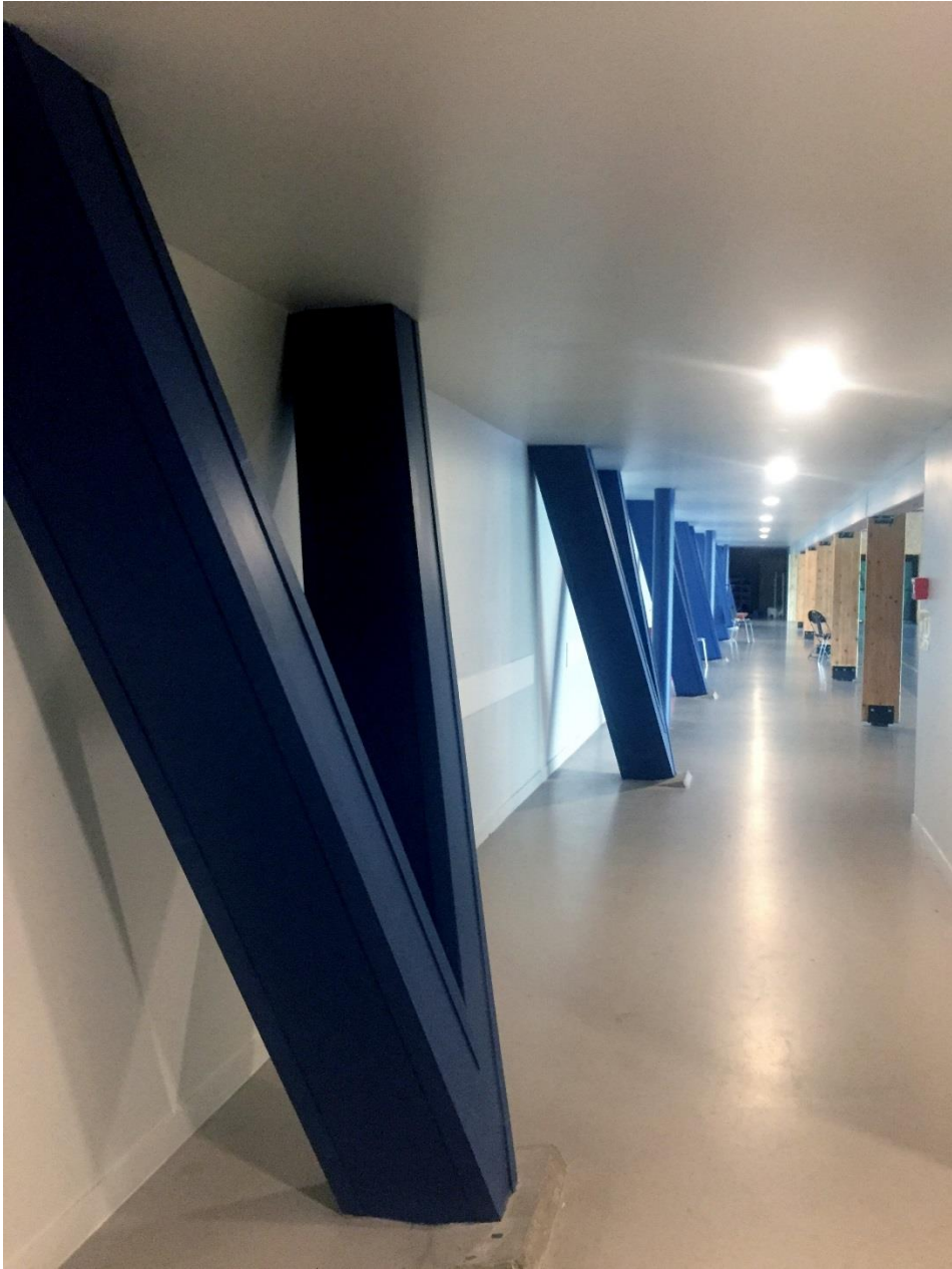
Éléments de structure du gymnase initial englobés dans une extension ultérieure. État 2019. Photo Anaëlle Lesné.
