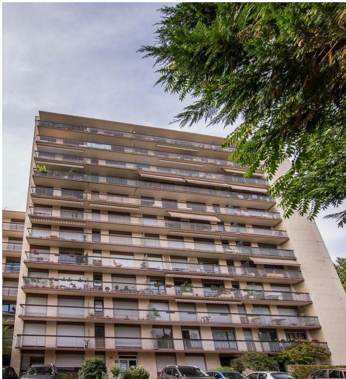
État 2017, façade de l'immeuble haut sur le passage privé. Photo Arnaud Lesné.
